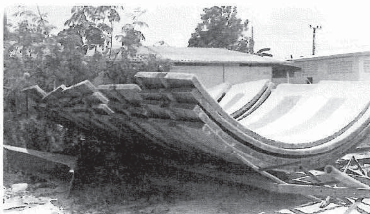
งานประกอบถังบำบัดก่อนแยกชิ้นส่วน (เตรียมขนส่ง)
