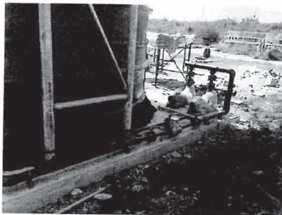
งานเดินท่อภายในระบบบำบัดน้ำเสีย
